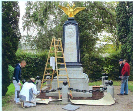
Gründliche und umfangreiche Sanierungs- und Restaurierungsarbeiten im Oktober 2013 am k.k. Marinegrabmal vom 9. Mai 1864
