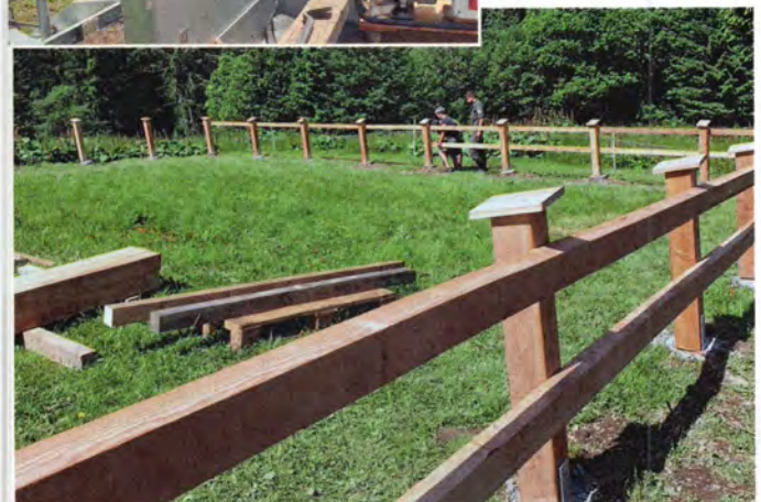
Ein großer Teil der Arbeiten ist bereits geschafft.
