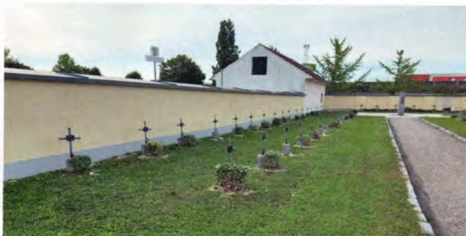
Die sanierte Friedhofsmauer mit neuer Blechabdeckung
