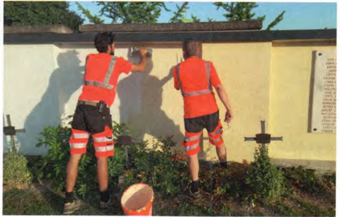
Bauhofmitarbeiter beim Verputzen der Friedhofsmauer
