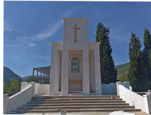
Kapelle nach der Renovierung
