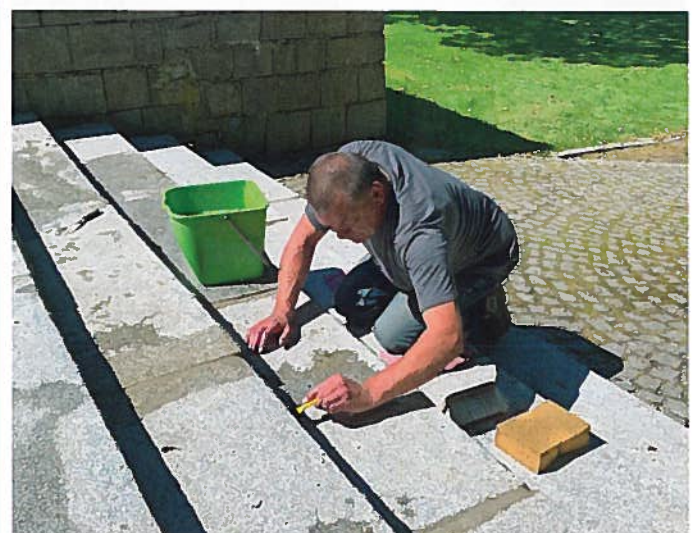
Friedhofsbetreuer Werner Eibensteiner beim Ausfugen der Treppenstufen
