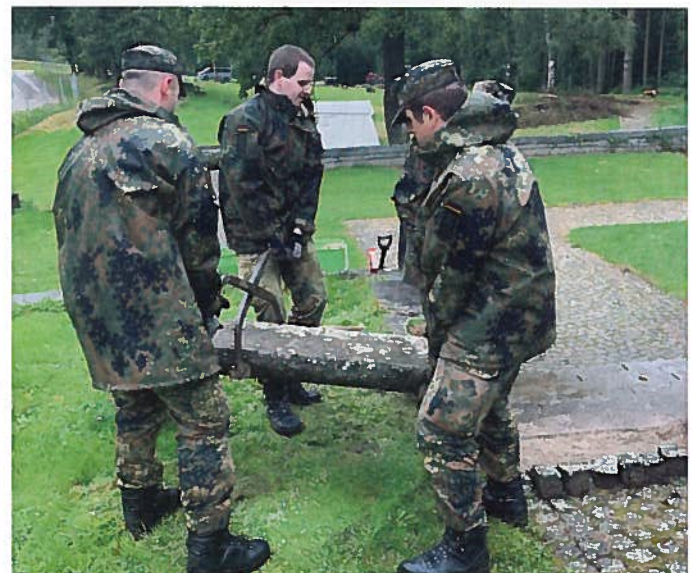
Neubefestigung der Stufenplatten
