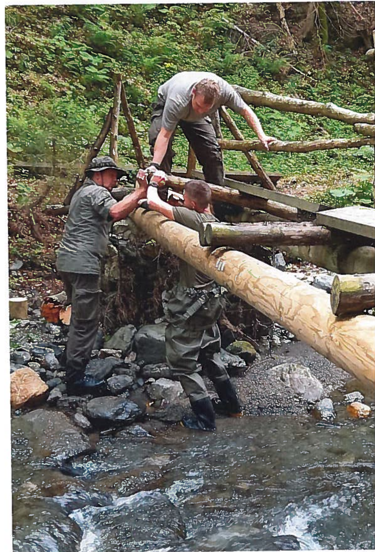
Auswechslung der kaputten Längsträger bei der Brücke über den Angerbach
