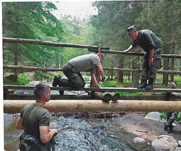
Auswechslung der kaputten Längsträger bei der Brücke über den Angerbach
