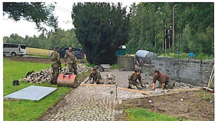
Pflasterungsarbeiten im Eingangsbereich
