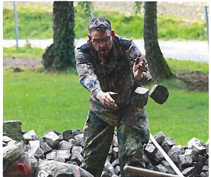
Pflasterarbeiten im Eingangsbereich
