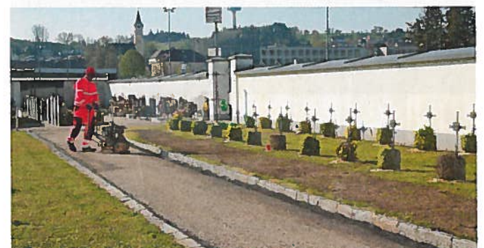
Bauhofmitarbeiter Britto Gutmann beim Asphaltieren des Weges
