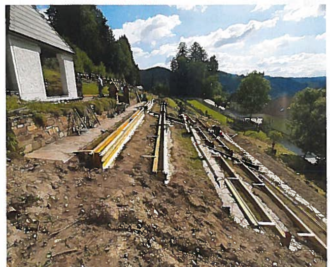
Erneuerung der Fundamente für die Grabkreuze
