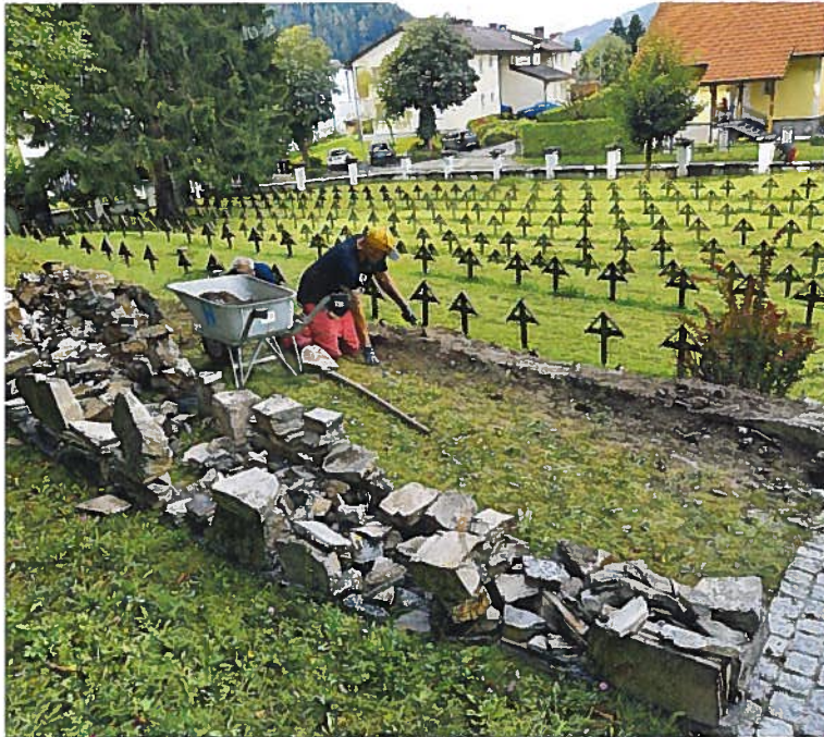
Sanierung der Stützmauer beim zentralen Mahnmal
