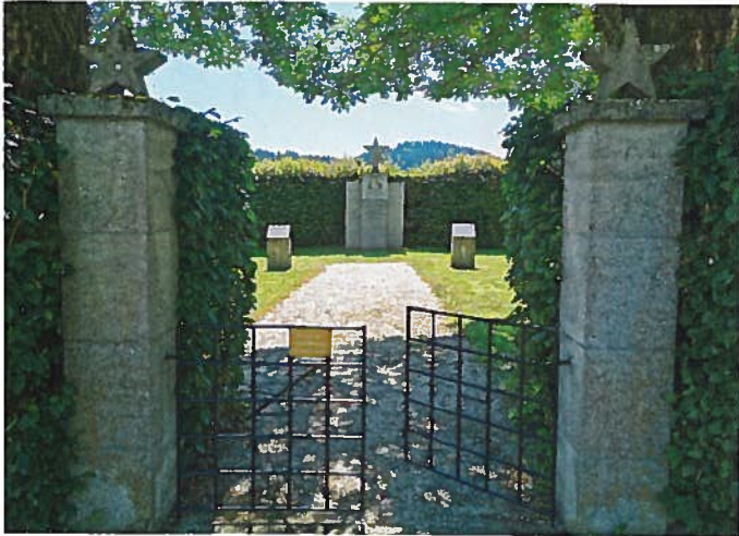
Im Vordergrund das entrostete und neu gestrichene Eingangstor
