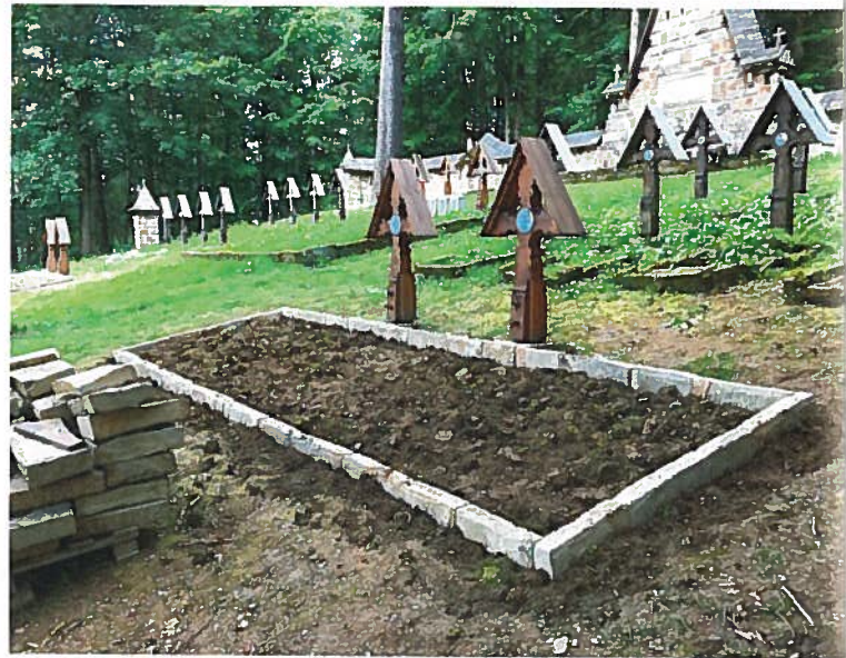
Verlegung neuer Bordsteinkanten bei den Gräbern am Kriegerfriedhof Nr. 61 Wirchne
