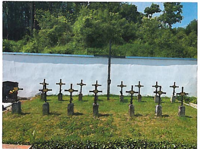
Der Soldatenehrenteil nach den durchgeführten Arbeiten
