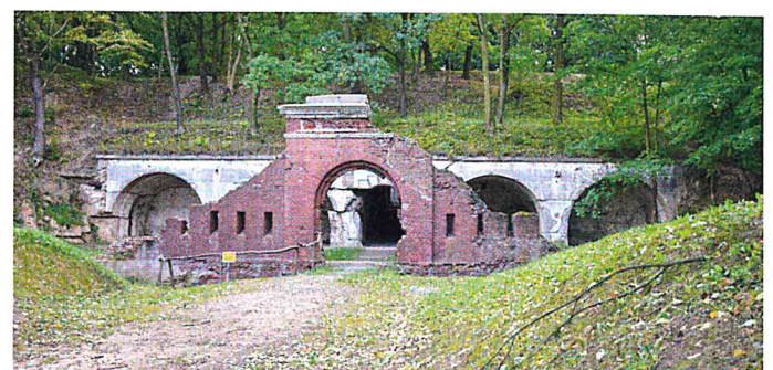
Eingang Fort Salis Soglio im Befestigungsgürtel Przemyśl
