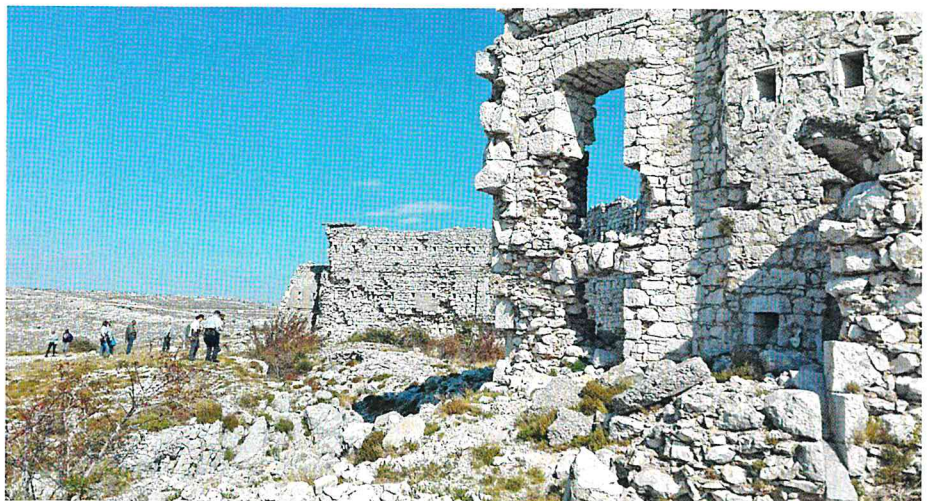
Eines der k.u.k. Festungswerke oberhalb von Mostar
