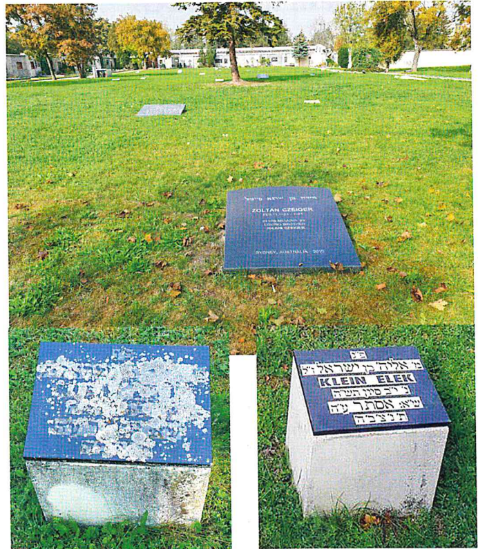
Tafeln vor und nach der Sanierung
