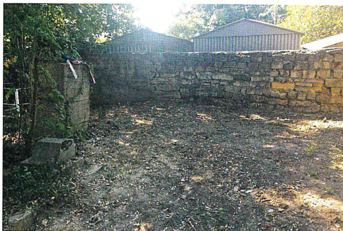
Der Friedhof vor der Sanierung durch das ÖSK
